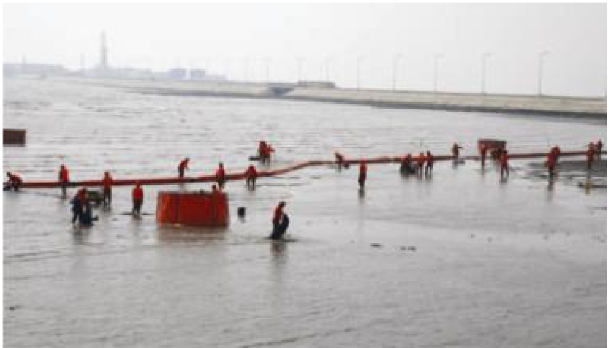
图 13 岸滩围油栏的布放方式二
